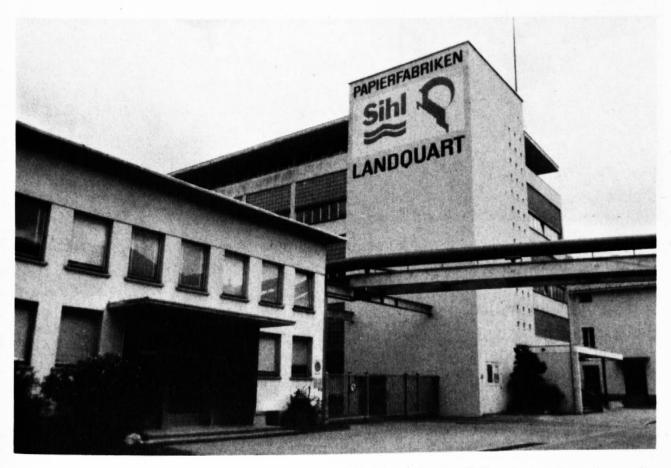
Die Papierfabriken Landquart, sie benützt heute noch den Mühlbach zur Energiegewinnung. Gut erkennbar ist auch die Dampfleitung, mit welcher Fernwärme aus der Kehrichtverbrehnung in Trimmis bezogen wird.
