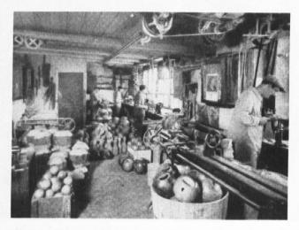
Drechslerei mit Transmissionsantrieb um 1912. Hauptprodukt Kegelkugeln aus Eisenholz. (Alte Werbekarte an der Drechslerei Eger in Sissach).
