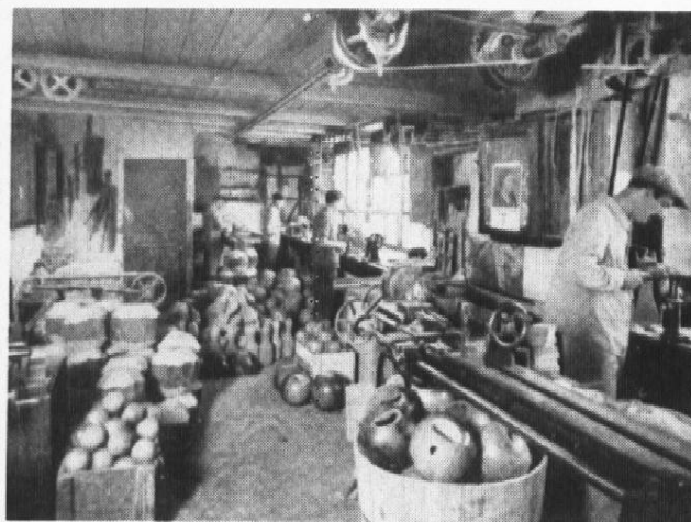
Drechslerei mit Transmissionsantrieb um 1912. Hauptprodukt Kegelkugeln aus Eisenholz. (Alte Werbekarte an der Drechslerei Eger in Sissach).
