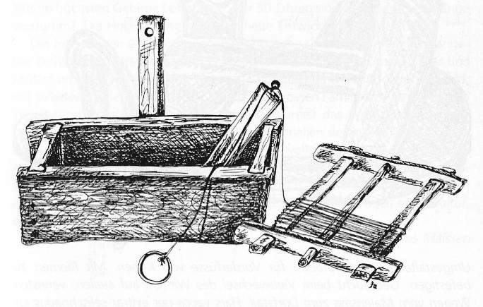
Schnurzeug und Russkübel für den Schnurschlag beim Behauen der Bauhölzer. Burtget, scav e corda che vegn tratga tras il lennet de tintga.
