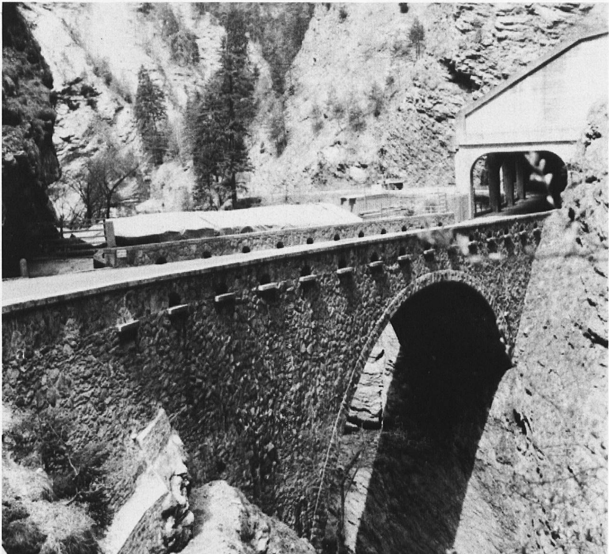
Brücke der Kantonsstrasse mit Galerie in der Viamala-Schlucht. Neben der Strassenbrücke die alte Wildener-Brücke aus dem Jahre 1738 (zugedeckt, in Renovation)
