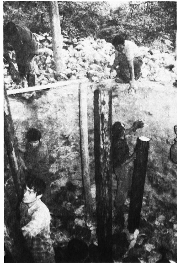
Einfüllen des Kalkofens mit Kalksteinen
