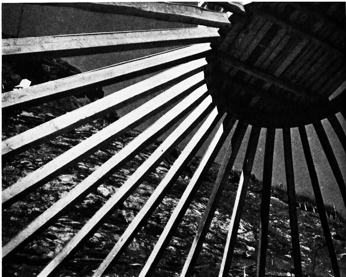
Kies- und Sandsilo-Abdeckung in Hetzerkonstruktion
