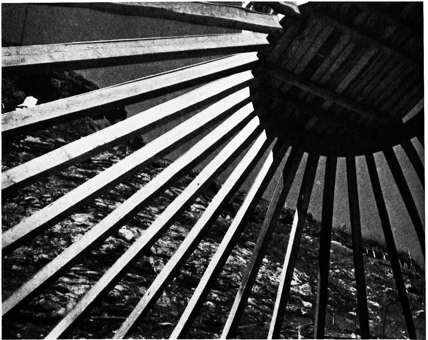
Kies- und Sandsilo-Abdeckung in Hetzerkonstruktion
