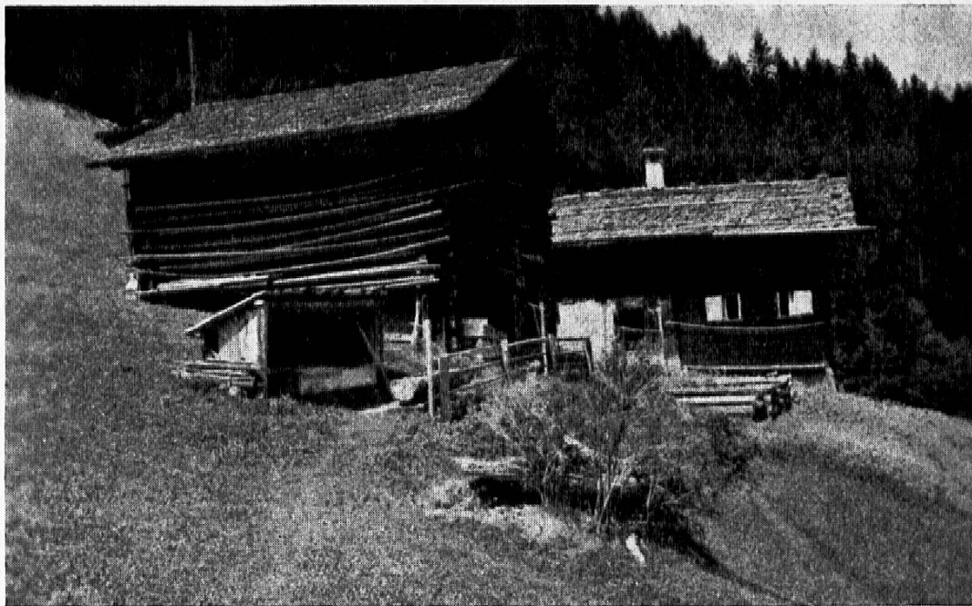
7 Haus mit Großviehstall, «Rüti» (Safien-Platz).
