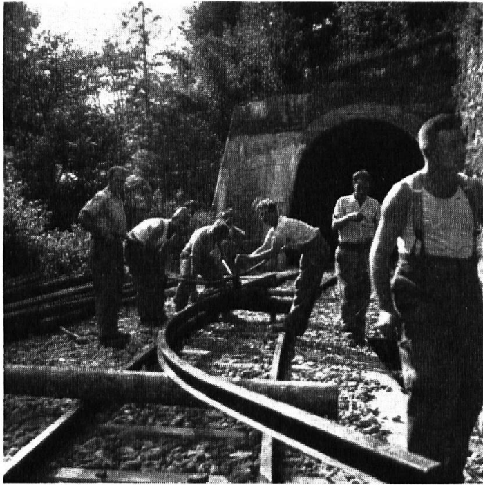
Das Biegen der Schienen für die Kurven
