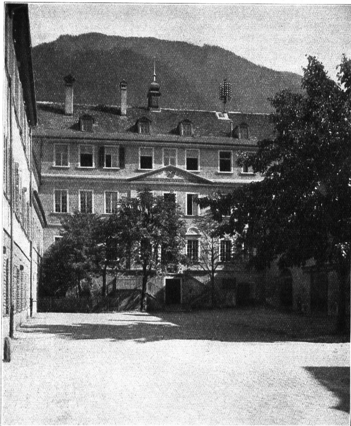
Alte Kantonsschule, jetzt Primarschulhaus
