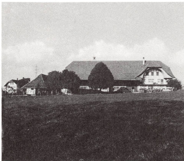
Ortsbildschutzgebiet Beispiel: Jatzikofen (Kirchlindach)
