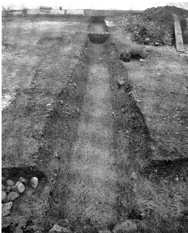
Fig. 16. Perly, villa gallo-romaine. Canal creusé dans le sol dans le prolongement de l'aqueduc maçonné. Photo SCA GE, D. Genequand.
