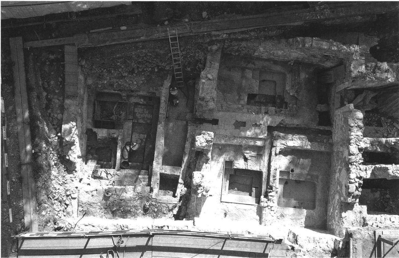
Abb. 49. Baden AG, Bäderquartier, «Hinterhof». Die ausgeschütteten Kellerräume mit ihren Bädern. Man beachte die unterschiedlichen Bassin-Typen des 17.-19. Jh.; hier im Bild die Typen 1-3, Mitte oben und ganz rechts. 1 mit Zementverputz; 2 holzverschalt (Teilrekonstruktion); links 3 langrechteckig mit Versatz und Holzverschalung. Foto KA AG.
