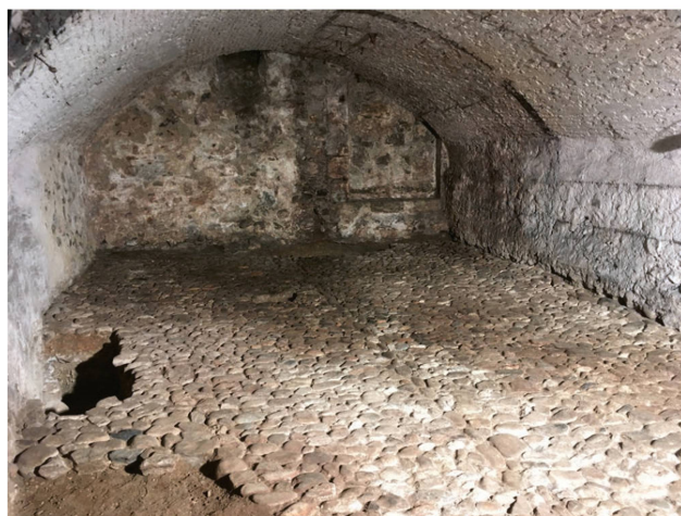
Fig. 13. Genève GE, maison Micheli. Cave A vue vers le sud. Voûte en berceau surbaissé, en briques (US141), sol en galets (US12) et au fond, mur M1. Photo SCA GE.
