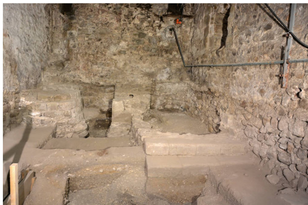
Fig. 11. Genève GE, maison Micheli. Moitié sud de la cave C. Au premier plan à droite, deux marches de l'escalier ST24, contre le mur M9. Au fond, le mur M8 et à gauche, la base de l'escalier ST27. Photo SCA GE.
