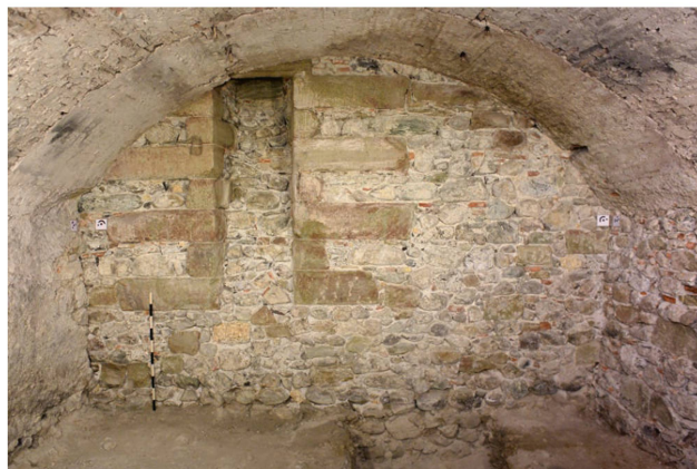
Fig. 14. Genève GE, maison Micheli. Mur nord de la cave A (M3), avec le soupirail B154, légèrement désaxé vers l'ouest. Photo SCA GE.
