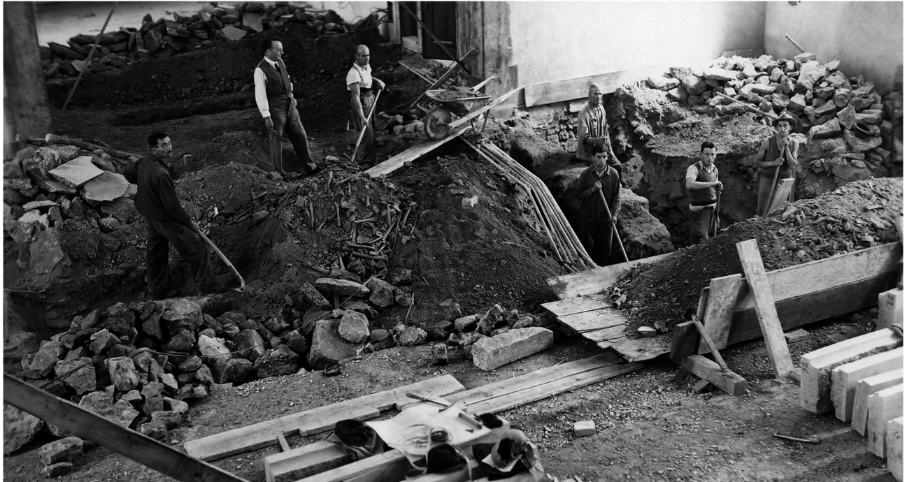
Abb. 12. Liestal BL, Stadtkirche. Grabung 1942, Blick vom Schiff in Richtung Chor. Bauarbeiter schaufelten Sondiergräben aus, die anschliessend vom jungen Geologiestudenten Hansjörg Schmassmann beschrieben und analysiert wurden. Die mit Menschenknochen und Mauersteinen durchsetzten Haufen zeigen, dass beim Aushub wenig zimmerlich vorgegangen wurde. Archiv Archäologie Baselland.
