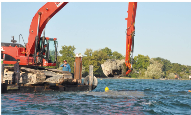
Abb. 10. Uttwil TG, Hügel 5. Der Bagger auf dem fixierten Arbeitsfloss über der Steinschüttung. Foto AATG, Matthias Schnyder.
