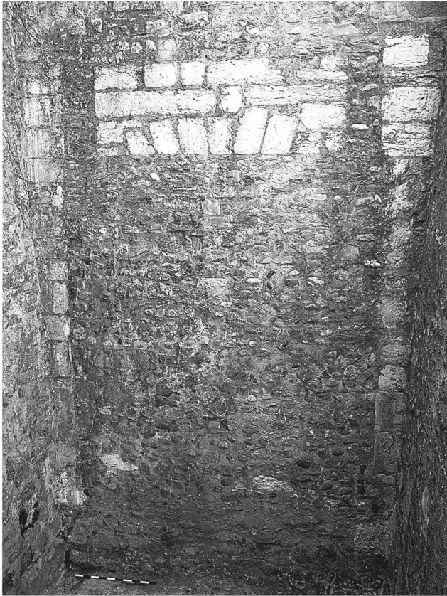
Fig. 68. Genève GE, Bastion de Saint-Léger. Porte d'accès à la ville murée, mise au jour dans le renforcement nord du bastion de Saint-Léger. Photo SA GE, G. Consagra.
