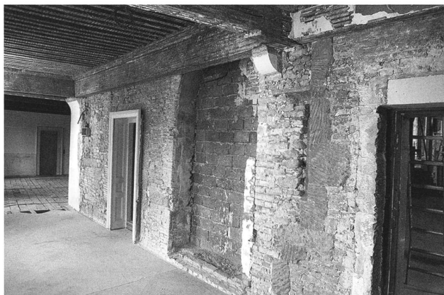
Fig. 51. Genève GE, Hôtel-de-Ville. Façade médiévale de la Maison de Ville partiellement conservée au deuxième étage de l'édifice actuel. Photo SA GE, E. Broillet-Ramjoué.
