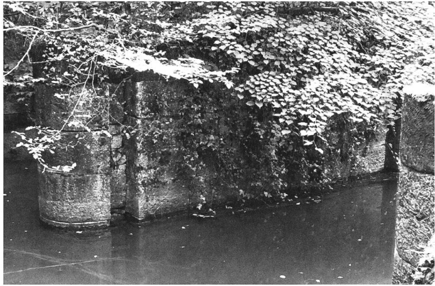
Abb. 69. Laufen-Uhwiesen ZH, Buechhalden. Blick vom Inseli auf einen Teil der nördlichen Wehrsperr. Gut erkennbar ist die vertikale Nut für eine hölzerne Falle. Foto KA ZH.
