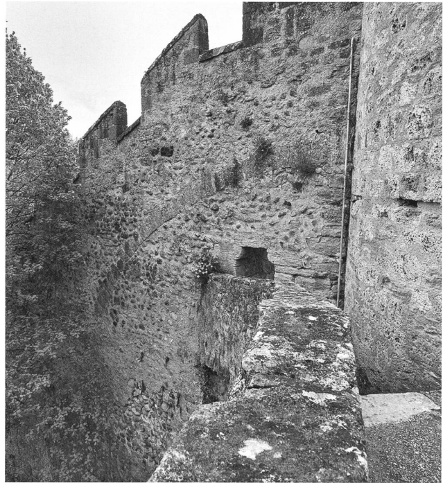
Fig. 52. Grandson VD, Château de Grandson. Vue de la partie supérieure du mur de braie oriental, parement extérieur avant travaux. Photo Rémy Gindroz.
