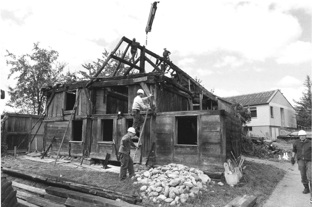
Abb. 70. Thunstetten BE, Kirchgasse 36. Das Gebäude während der Abbauarbeiten. Foto ADB, C. Gerber.
