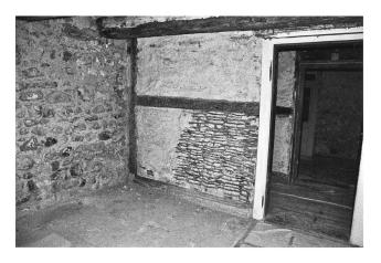
Abb. 52. Stein am Rhein SH, Brodlaubegass 15/Obere Sonne. Raum 009, SE-Ecke. Blick auf das teilweise freigelegte Rutengeflecht und das Bollensteinmauerwerk des Hinterhauses. Foto KA SH.
