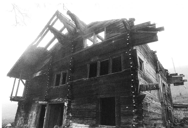
Abb. 52. Adelboden BE, Hirzbodenportstrasse 10. Der Abruch des Hauses wurde von Mitarbeitern des Archäologischen Dienstes begleitet, und dabei entnahm man Hölzer für dendrochronologische Analysen. Im Untergeschoss lag der Stall, südostseitig befand sich oberhalb des Kleinviehstalls das Stubengeschoss und das Gadengeschoss des Wohnteils. Auf der südöstlichen Traufseite wurde die Laube bereits abgebrochen. Blick nach Nordosten. Foto ADB, M. Amstutz.
