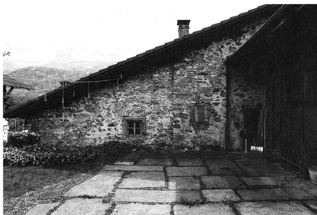
Abb. 53. Brienz BE, Oberdorfstrasse 92/94, Geigenbauschule. Die als Steinbau ausgebildete mehrphasige Rückfassade des sonst als alpiner Blockbau errichteten Gebäudes. Foto ADB, D. Breu.
