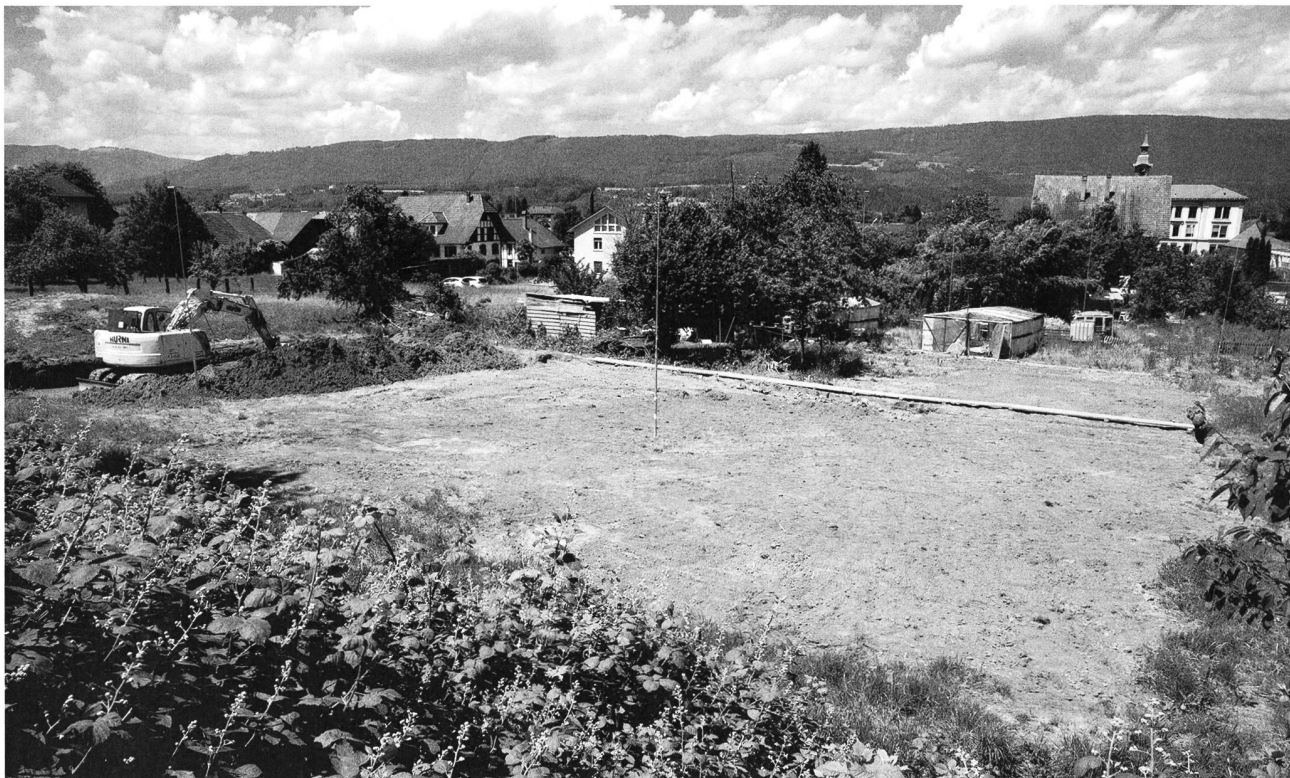
Fig. 2. Büren an der Aare, Aarbergstrasse 5, 7, 9. Situation de la zone fouillée, vue vers le nord-ouest. Photo SAB, M. Maire.
