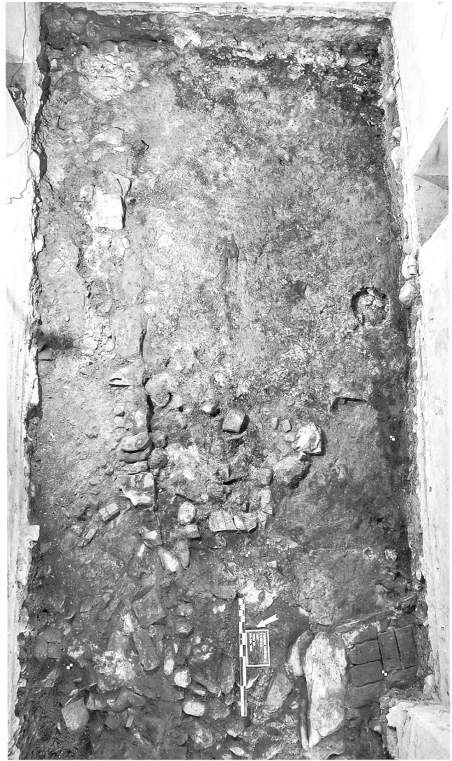
Abb. 44. Flüelen UR, Dorfstrasse 3, Raum R0.03. Links die West-Ost verlaufende Steinreihe, Fundament einer ehemaligen Holz- oder Fachwerkwand, mit südlich daran angrenzendem, stark hitzegeröteten Lehmbo den der offenen Rauchküche. Zu erkennen sind das Fundament einer abgehobenen Herdstelle (Bildmitte) sowie die Feuerstelle aus Steinplatten und Backsteinen (rechte untere Bildecke). Foto ProSpect GmbH.
