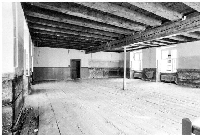
Fig. 66. Fribourg FR, Collège St-Michel. Plancher et poutraison d'origine du premier étage de bibliothèque après la dépose du plafond à caissons, vers 1659. Photo SAEF, G. Bourgarel.
