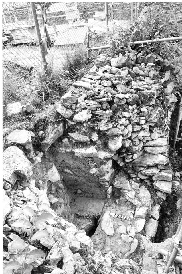
Abb. 51. Luzein GR, Putz, Burganlage Castels. Südmauer (M8) – Schnitt 9. Die Trockensteinmauer wurde der älteren Umfassungsmauer vorgesetzt. Im Sondageschnitt kamen eine Maueröffnung und Reste eines Mörtelbodens zum Vorschein. Foto AD GR.
