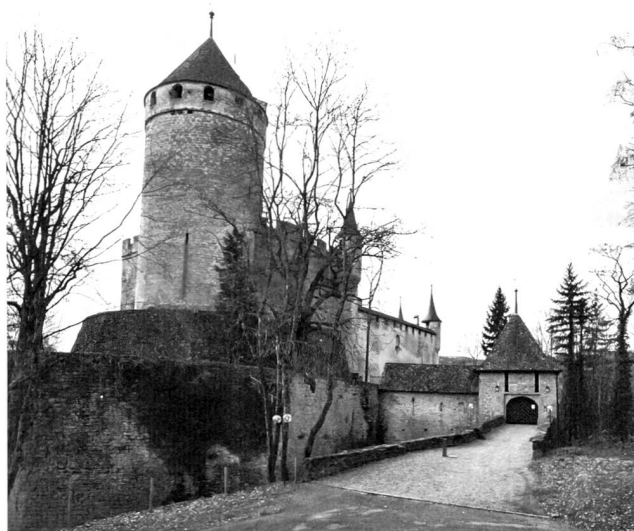
Fig. 69. Lucens VD, Terrasses du château et Porte de Combremont. Vue du château de Lucens en direction de l'ouest, avec la façade orientale de la tour de Combremont avant travaux. Photo Archéotech SA, Epalinges.
