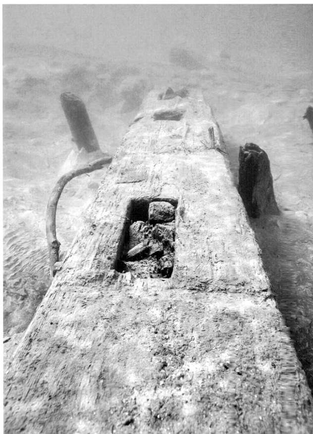
Abb. 71. Salenstein TG, Mannenbach Schiffsteg. Mit Eichenpfählen am Seegrund verankerte Fichtenbalken mit Zapflöchern für eine aufgehende Konstruktion. Foto AA TG.
