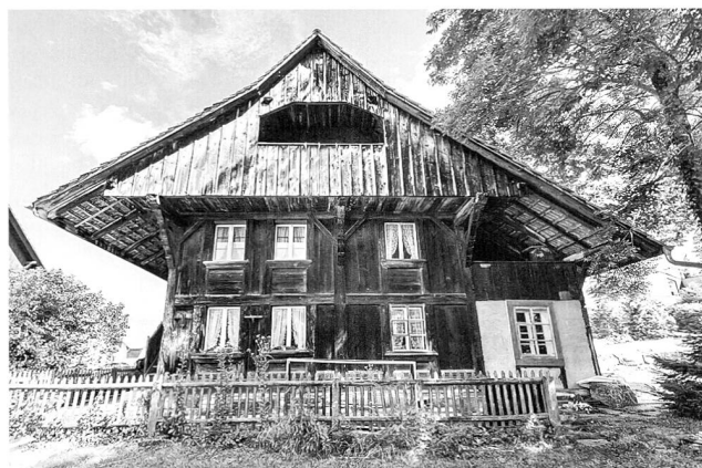
Abb. 70. Niederlenz AG, Schürz 8 (Nlz.016.1). Südfassade des Bohlenständerbaus (um 1780). Foto KA AG, Th. Frey.
