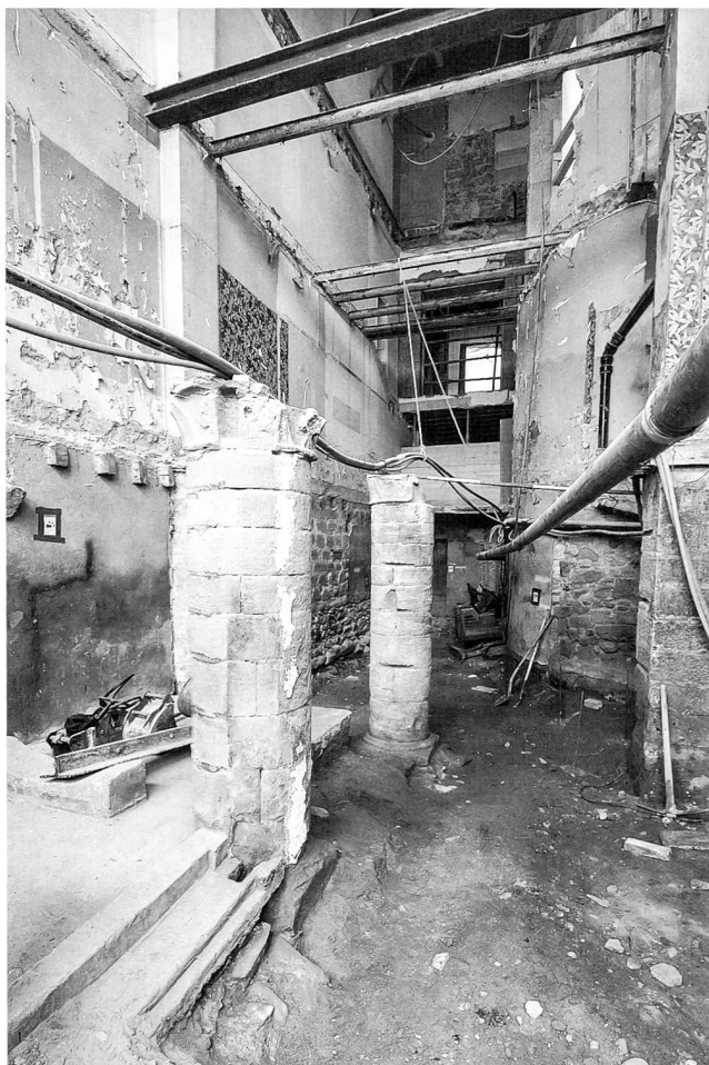
Fig. 50. Lausanne VD, Rue de Bourg 8. Vue générale de la cave en direction du sud avec deux colonnes dégagées. Photo Archéotech SA.
