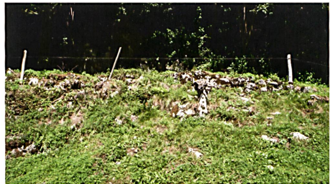
Abb. 9. Lungern OW-Alter Passweg, Abschnitt 2 (OW 2015.002). Blick vom Sewli-Dossen (Osten) auf die aus grossen Kalksteinen errichtete Trockenmauer, welche die talseitige Begrenzung des Passwegs in der Flur Cholhüttliwald bildet. Blick nach Norden. Foto S. Chamberlain.
