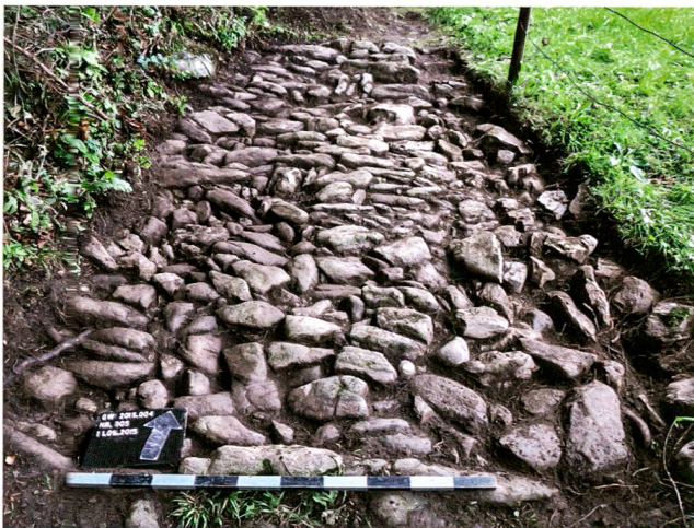
Abb. 11. Lungern-Alter Passweg, Abschnitt 4 (OW 2015.004). Blick nach Norden auf die spätmittelalterliche oder (früh-)neuezeitliche Pflasterung des Passweges in der Flur Oberhus. Foto L. Christen.
