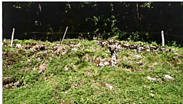
Abb. 9. Lungern OW-Alter Passweg, Abschnitt 2 (OW 2015.002). Blick vom Sewli-Dossen (Osten) auf die aus grossen Kalksteinen errichtete Trockenmauer, welche die talseitige Begrenzung des Passwegs in der Flur Cholhüttliwald bildet. Blick nach Norden. Foto S. Chamberlain.
