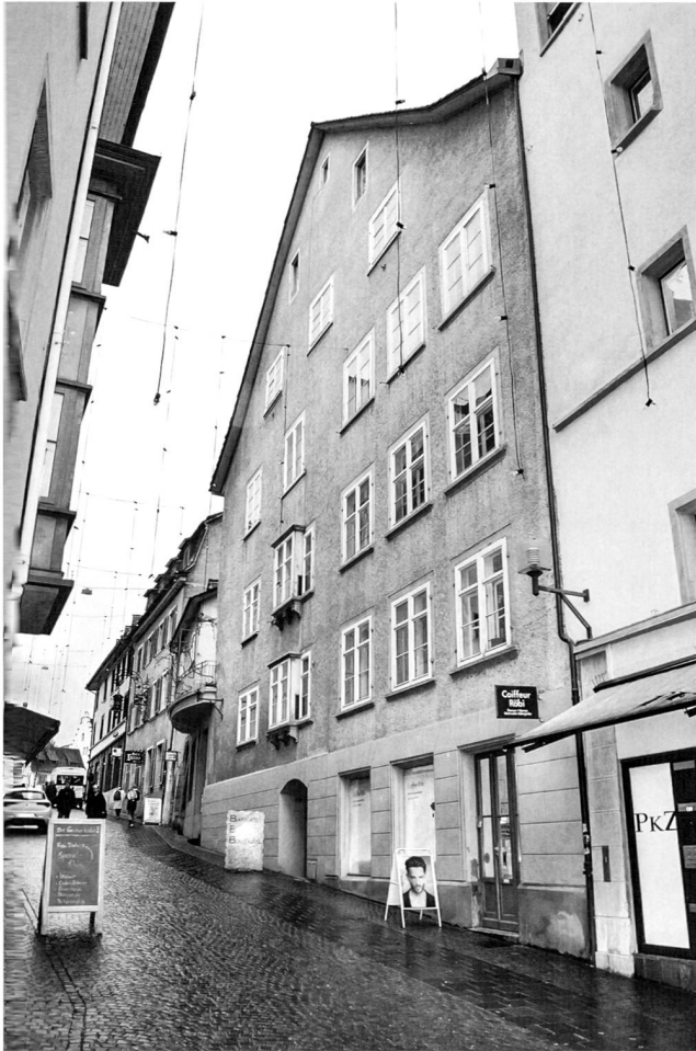
Abb. 2. Schaffhausen. Liegenschaft Zur Oberen Tanne gegen Süden, Zustand 2012. Foto G. Faccani, Zürich.
