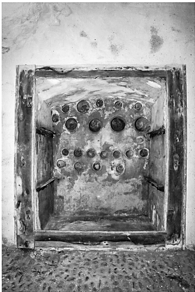
Abb. 7. Schaffhausen, Zur Oberen Tanne . Keller B. Nische nach der Entfernung der Regalbretter. Zustand August 2014. Blick gegen Osten. Foto G. Faccani, Zürich.
