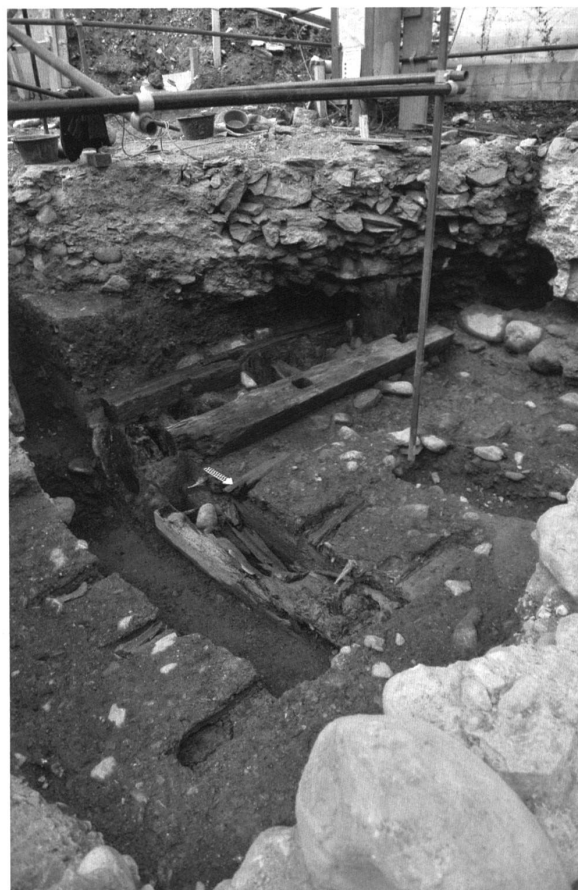
Abb. 55. Chur GR, Münzmühle. Hölzerne Konstruktion des mit Wasser betriebenen Hammerwerkes (16. Jh.?). Foto AD GR.
