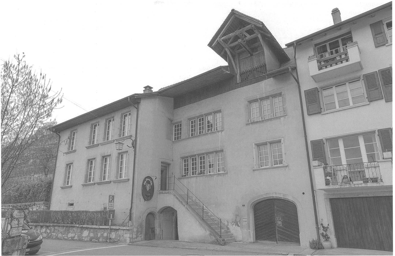
Abb. 60. Ligerz BE, Chlyne Twann 7. Südfassade. Deutlich stehen die Süderweiterung und der nachträglich angebaute Hocheingang ins Auge. Blick nach Nordwesten. Foto ADB.
