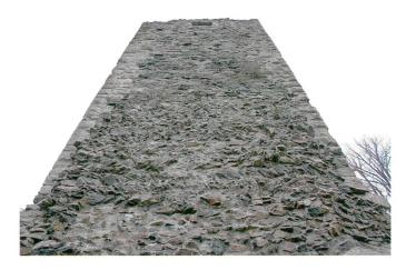
Abb. 25. Laufenburg-Schlossberg. Die Südfront besteht im unteren Bereich aus einer Mauer im Ährenverband. Foto F. Tortoli.
