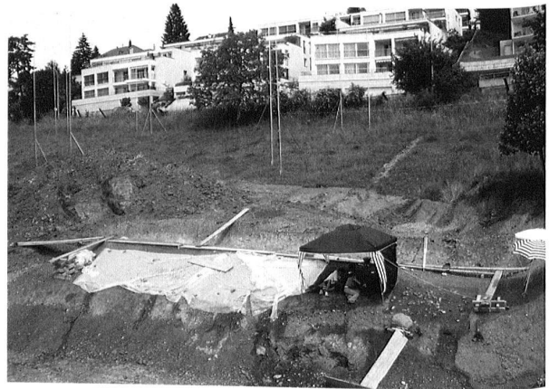
Abb. 2. Wil SG, Fürstenaupark. Feingrabung in Feld 1 oberhalb der Baugrubenböschung, Juni/Juli 2006. Foto KA SG.
