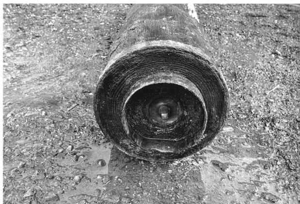
Fig. 55. Echallens VD, Place des Balances 1. Le système de soupape à la jonction des deux éléments de bois. Photo Archéotech SA, C. Laurent.
