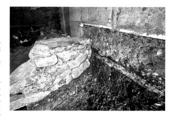
Abb. 37. Basel BS, Petersgasse 36. Mit gelbem Schwemmlehm «vermörteltes» Steinfundament eines (Fachwerk?)Hauses. An seiner Aussenseite entsprechend auf das Gehniveau verstürzter Brandschutt und darunter ein Lehmestrich. Foto ABBS.
