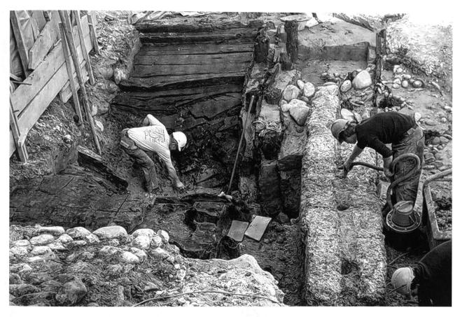
Abb. 18. Baden AG, Bäderquartier, Limmatknie. Verstürzte Holzkonstruktion, die eine geologische Störung überbrückte, und ihre seitliche Schalung. Foto KA AG.
