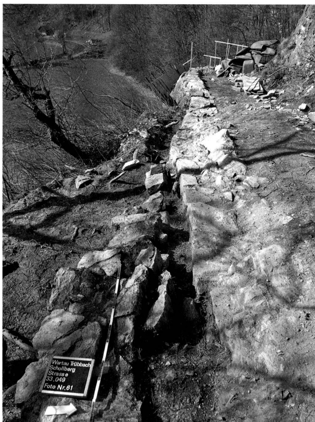
Abb. 52. Wartau SG, Alte Schollbergstrasse. Wegstrecke bei der exponierten Stelle an der Hohwand: Eine Stützmauer (rechts im Bild) sichert die Strasse an der steil abfallenden Felskante (ganz hinten im Bild). Sie wurde durch eine jüngere Stützmauer (links im Bild) bei einer Strassenverbreiterung ersetzt. Foto KA SG.
