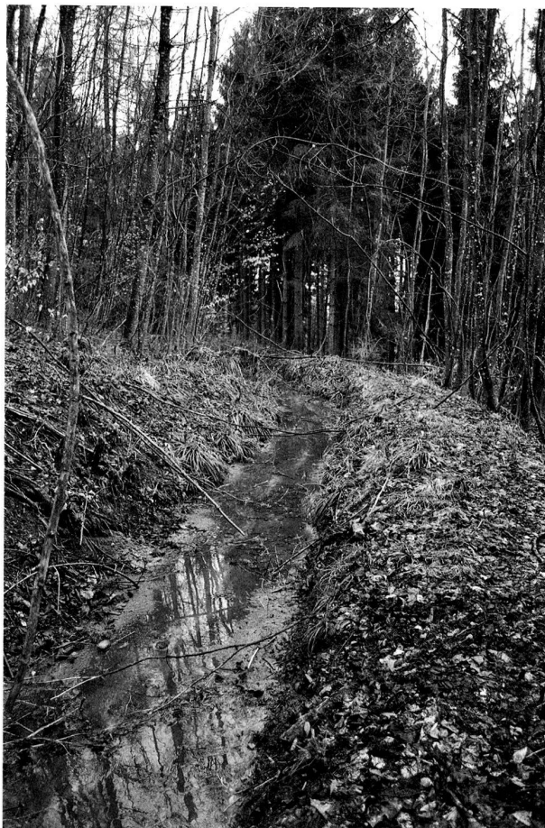
Abb. 48. Buchs ZH, Berg. In den Hang gebauter Kanal des Mötschenbachs. Foto U. Bodmer, Stadel.
