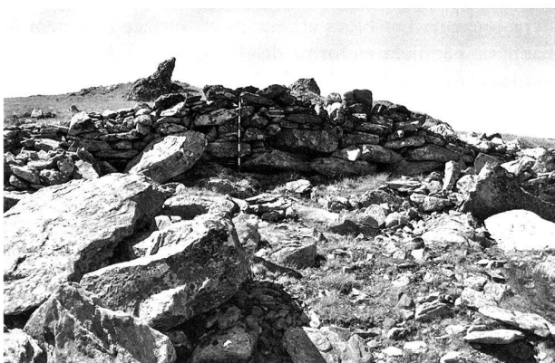
Fig. 9. Liddes VS, Mur (dit) d'Hannibal. Tronçon conservé du parement extérieur du mur d'enceinte (M39). Vue vers l'ouest. Photographie R. Andenmatten TERA Sàrl.
