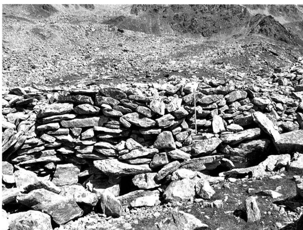
Fig. 8. Liddes VS, Mur (dit) d'Hannibal. Tronçon conservé du parement intérieur du mur d'enceinte (M39). Vue vers l'est. Photographie R. Andenmatten TERA Sàrl.
