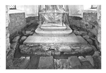
Abb. 45. Egg SZ, Etzelpasshöhe, Kapelle St. Meinrad. Blick nach Osten ins Chor mit teilweise freigelegten Belüftungskanälen unter dem Chorboden der 2. H. 18. Jh. Foto G. Sidler, Schwyz.
