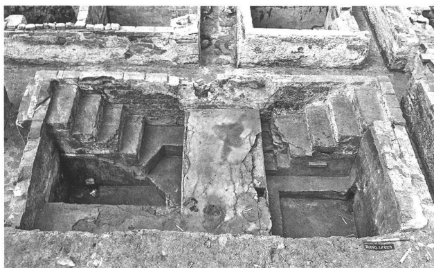
Abb. 43. Baden AG, Bäderquartier, «Limmatknie». Blick in zwei mit Zement ausgestrichene Unterflurwannen (2. H. 19. Jh.) des «Staadhofes». Vom (nicht erhaltenen) Korridor über dem Reservoirsystem führt eine vierstufige Treppe ins Bad hinunter. Zum Baden wird bei einem Wasserstand von ca. 50 cm im Bassin gesessen. Foto KA AG.
