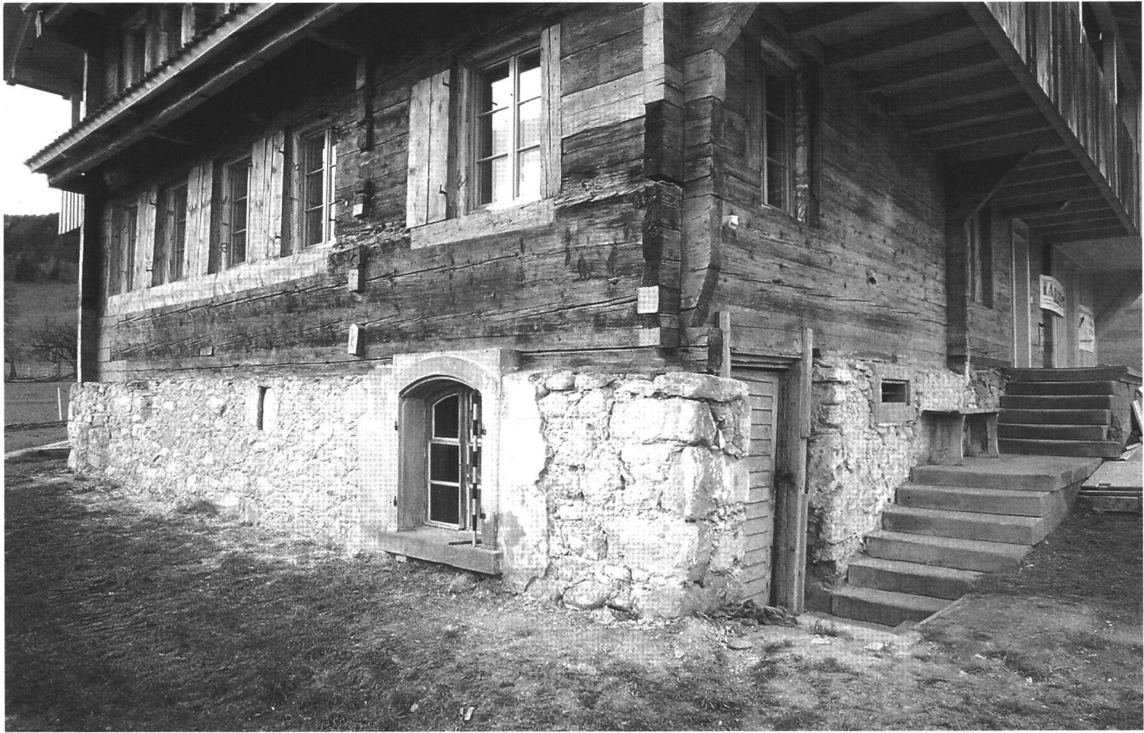
Abb. 58. Unterägeri ZG, Unterblacki. Der Kellersockel und der darauf ruhende, ins Jahr 1509/10 datierte Blockbau kurz vor Abschluss der Restaurierung. Foto KA ZG, M. Camenzind-Nigg.
