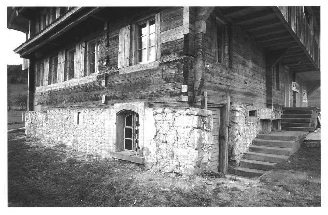
Abb. 58. Unterägeri ZG, Unterblacki. Der Kellersockel und der darauf ruhende, ins Jahr 1509/10 datierte Blockbau kurz vor Abschluss der Restaurierung. Foto KA ZG, M. Camenzind-Nigg.
