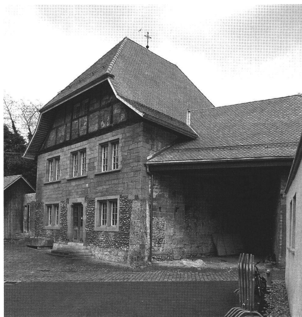
Fig. 57. Fribourg, Commanderie de St-Jean. Vue générale après les travaux. Photo SAEF, G. Bourgarel.
