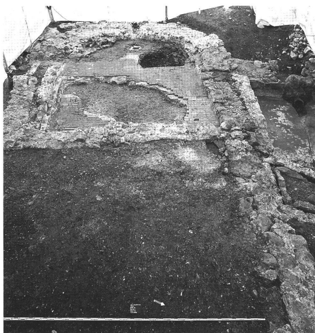
Abb. 52. Thun BE, Bälliz 30. Stadtmauer und halbrunder Schalenturm. Foto ADB.
