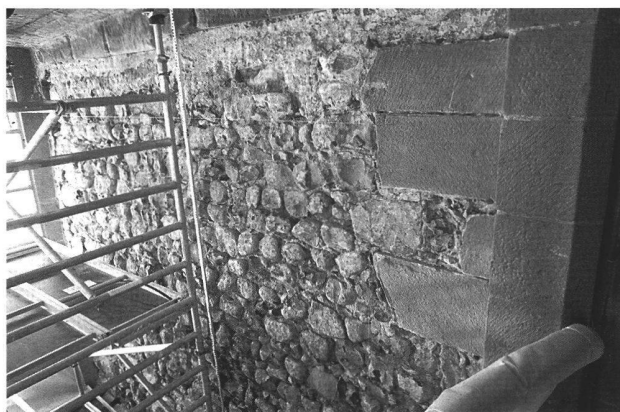
Abb. 53. Zug ZG, Kolinplatz 12, Zitturm. Blick von der Altstadt in die Tordurchfahrt Richtung Norden. Das äusserst regelmässige, originale Mauerwerk der Zeit um 1300 ist brandversehrt. Die Sandsteinquader vorne links bilden den inneren Torbogen und stammen von 1480. Foto KA ZG, M. Bolli.
