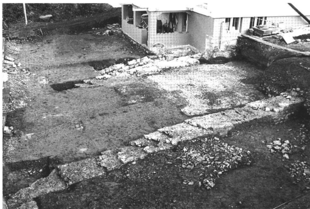
Abb. 20. Augst BL, Augusta Raurica, Südforum (Grabung 2008.053). Übersicht von Südosten. Vorn die fast 1 m breite Mauer, dahinter freigelegt der erwähnte Bauhorizont, ganz hinten beim bestehenden Wohnhaus der Abwasserkanal. Im Hintergrund Mitte römische Mauerzüge, auf die das 1936 errichtete Wohnhaus teilweise fundamentiert worden ist. Foto Augusta Raurica.
