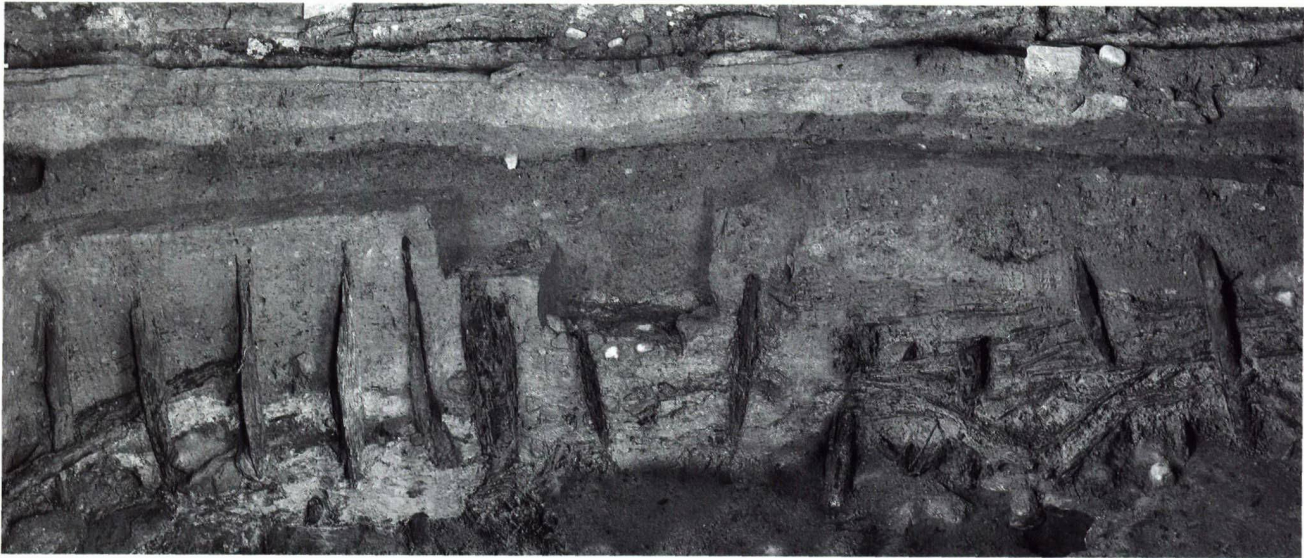
Abb. 38. Luzern LU, Mühlenplatz 3-4. Hochmittelalterliche Aufschüttung zur Landgewinnung an der Reuss, mit umflichtener Pfahlreihe zur Stabilisierung der Schüttung. Aufliegend mehrere Planien mit Gelniveaus, am oberen Bildrand Lehm Böden in einem Holzhaus des 13. Jh. Foto KA LU, A. Herger.
