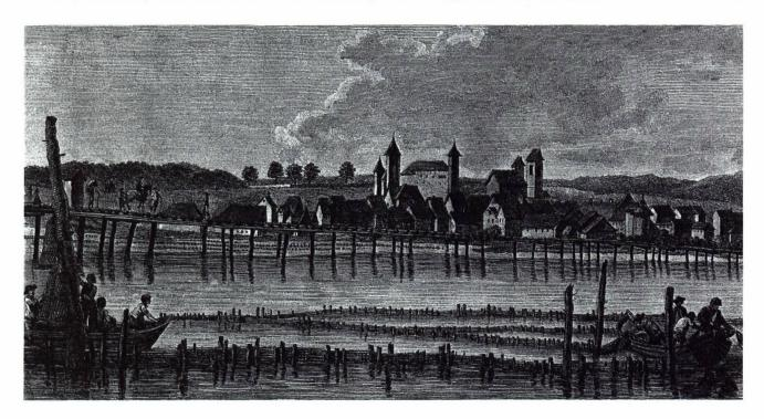
Abb. 14. Kupferstich mit der Silhouette der Stadt Rapperswil. Im Vordergrund sind zwei Fischerboote zu sehen, die zwischen den Fachen Reusen einholen. Im Hintergrund ist zudem eine einfache Pfahljochbrücke zu erkennen, die etwa 2 m über der Wasseroberfläche verläuft. Kupferstich Jacques Barbier, «Ile Vue de la Ville de Raperchwille», um 1777–1788.
