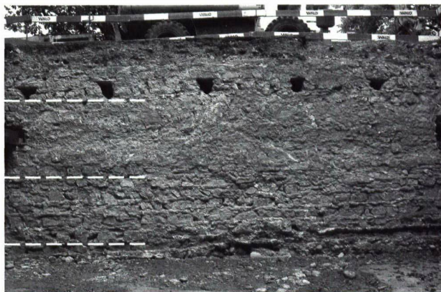
Abb. 28. Basel, Klingentalgraben 28. Ansicht der Rückseite der äusseren Grabenmauer nach dem Abtragen des Walls. Die gestrichelten Linien deuten die drei Bauetappen an. An der Basis der obersten Etappe ist eine Reihe von Gerüstbalkenlöchern zu erkennen. Foto ABBS.
