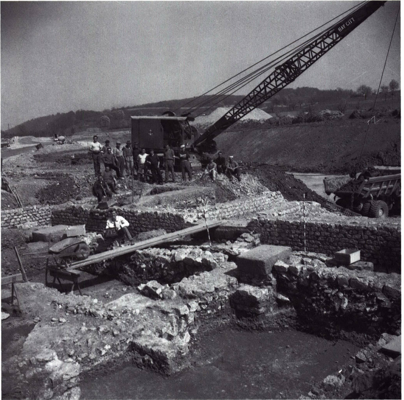
Abb. 6. Augst BL. Ausgrabung im Vorfeld des A2-Baus. Unter extremem Zeitdruck wurden Teile der südlichen Vorstadt Augusta Rauricas untersucht. Nach Ur-Schweiz 1967, 37, Abb. 29.
