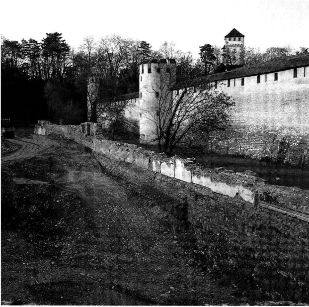
Abb. 39. Basel BS, St. Alban-Rheinweg 118–126 (Mühlegraben). Blick nach Süden über Baugrube, Kontermauer, Stadtgraben und Stadtmauer (im Hintergrund das St. Alban-Tor). Auf den Fundamenten der Kontermauer stand bis 2005 ein Fabrikgebäude (verputzte Stellen). Foto Ch. Matt.
