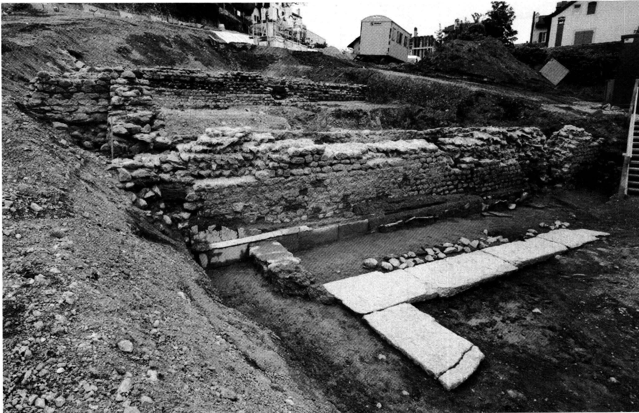
Fig. 31. Nyon VD, La Duche. Mur de fermeture nord-ouest du portique, vue nord. Photo Fibbi-Aeppli, Grandson.
