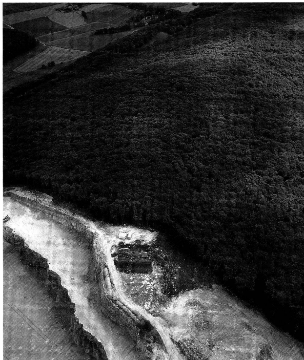
Fig. 1. Vue aérienne du site en cours de fouille. Photo Y. André.
