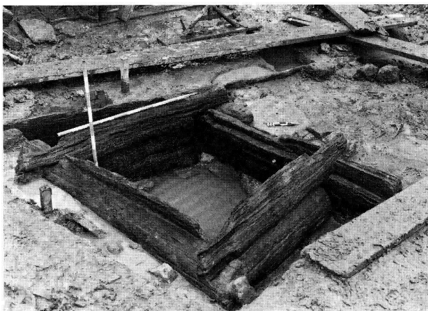
Fig. 7. Avenches VD, Sur Saint-Martin. Puits romain daté de 170 env. apr. J.-C.; vue de son cadre en bois de chêne. Photo J. Morel.
