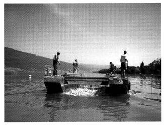
Abb. 4. Sutz-Lattrigen BE, Hauptstation. Verlegen des Geotextils (links) mit Hilfe des eigens für die Schutzmassnahmen gebauten Katamarans mit verklappbarem Jalouisieboden für das Einbringen der Kiesschüttung (rechts).
