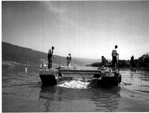
Abb. 4. Sutz-Lattrigen BE, Hauptstation. Verlegen des Geotextils (links) mit Hilfe des eigens für die Schutzmassnahmen gebauten Katamarans mit verklappbarem Jalousieboden für das Einbringen der Kiesschüttung (rechts).
