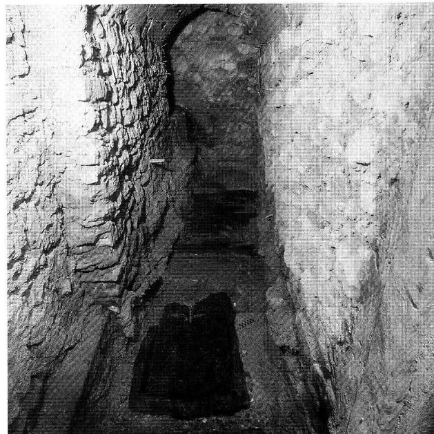
Abb. 38. Studen BE, Rebenweg/Petinesca. Blick in den heutigen Quellschacht. Das Holzbecken im Vordergrund diente im 2. Jh. als Sandabscheider. Foto ADB.
