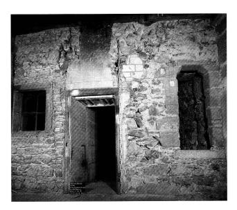
Abb. 33. Bern BE, Brunngasse 56. Blick auf die Nordseite der Stadtmauer mit jüngeren Durchbrüchen und Unterfangungen. Rechts die Kragsturztür des 13. Jh. Photo ADB, D. Kissling.
