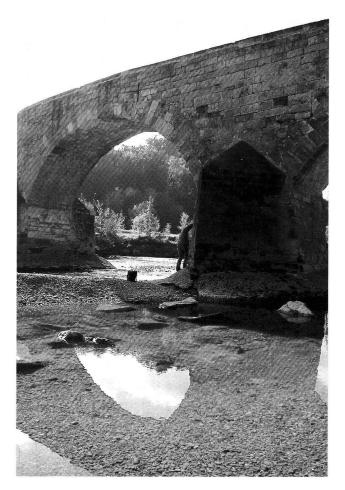
Abb. 34. Bischofszell TG, Thurbrücke. Beginn der Renovationsarbeiten an der im späteren 15. Jh. errichteten Steinbrücke. Photo Amt für Archäologie TG.
