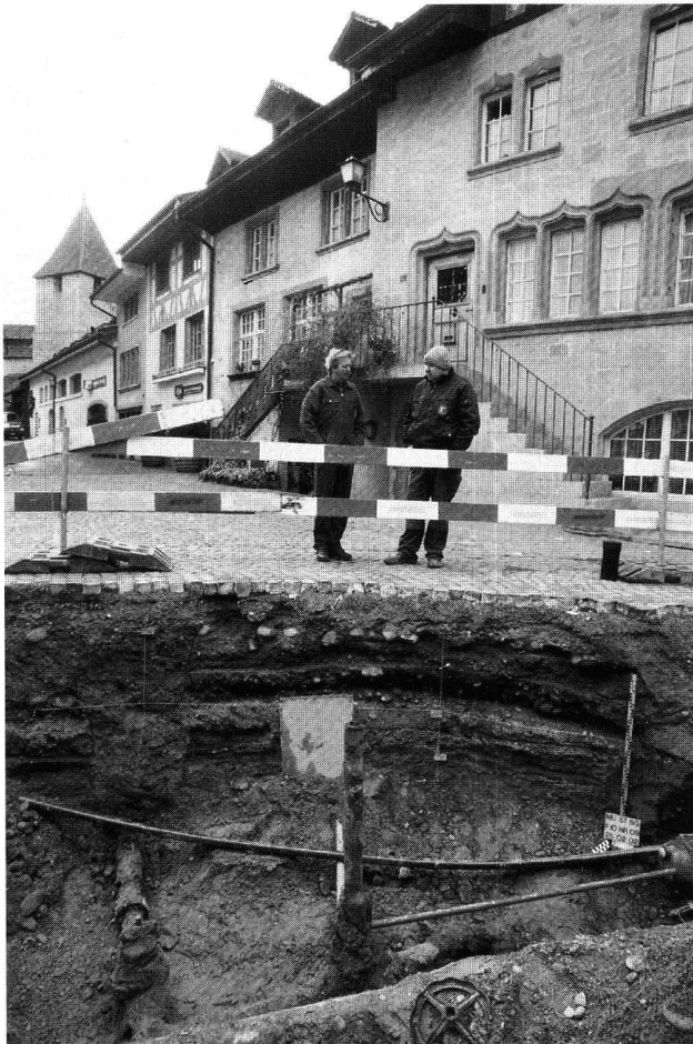
Fig. 44. Murten FR, Schlossgasse. Vue générale des travaux. Photo SAEF, C. Kündig.
