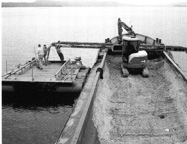
Abb. 2. Sutz-Lattrigen BE, Lattrigen Hauptstation-aussen. Schutzmassnahmen: a das mit Eisengitter verstärkte Geotextil wird gewässert und b auf dem Seegrund fixiert; c das Kies wird gleichmässig auf das Spezialponton verladen und d anschliessend über dem Geotextil eingebracht. Photos ADB.
