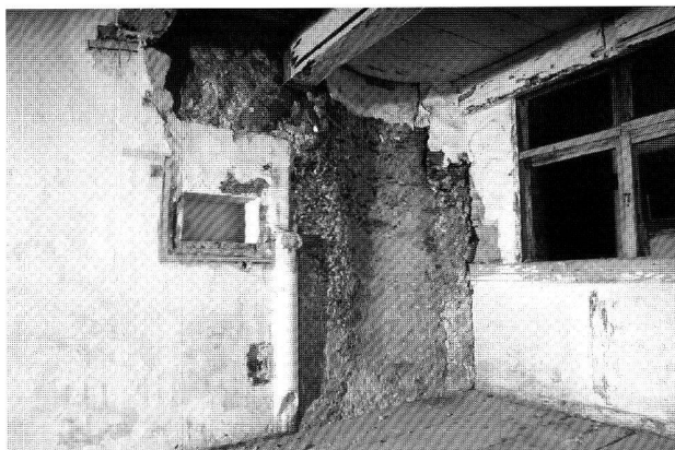
Abb. 40. Winterthur, Obere Kirchgasse 6. Im 1. Obergeschoss waren Teile einer Kaminanlage (Nische, Halbsäule, Kaminzug) des 1197 (dendrodatiert) erbauten Gebäudes erhalten. Photo KA ZH.
