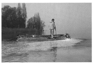
Abb. 26. Ermatingen-Westerfeld. Einbringen des Kieses über Druckleitung und Ponton, November 1998. Aufnahme AATG, T. Rey.
